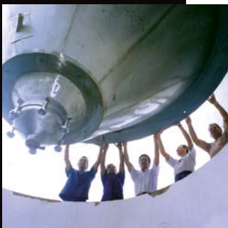
Einsetzen eines Tanks in den Betonsockel
