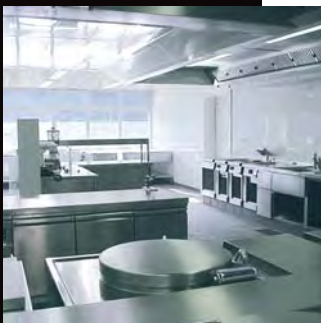
Teil der neuen Küche
