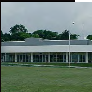
Nach der Sanierung mit neuem Dachaufbau
