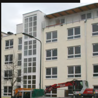
Fassade Werstener Feld in der Bauzeit
