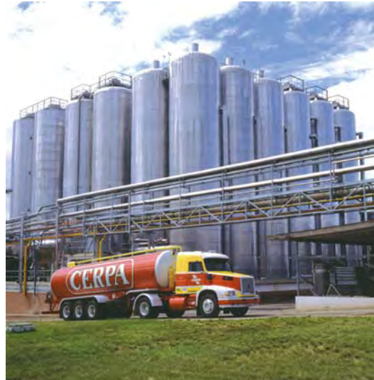
Blick auf den Komplex
