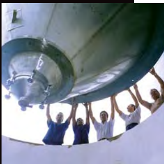
Einsetzen eines Tanks in den Betonsockel
