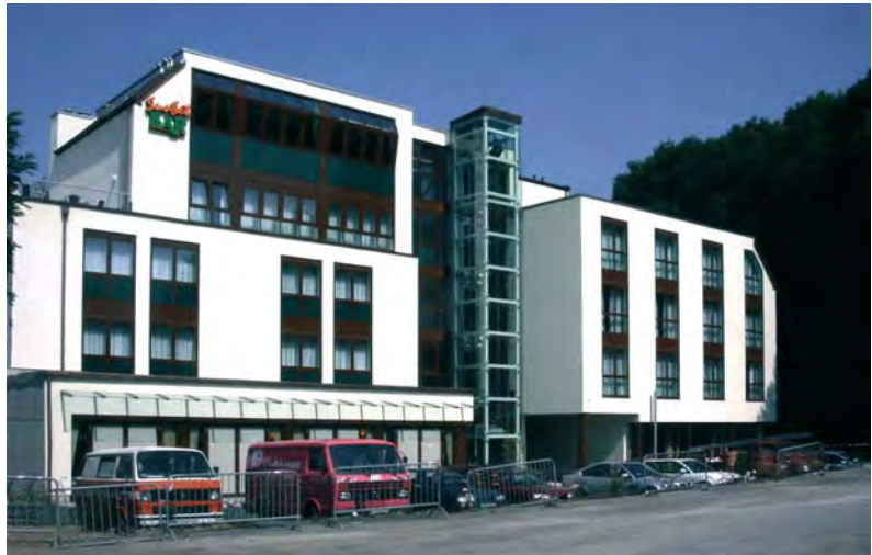
Ostfassade des Erweiterungsbaus
