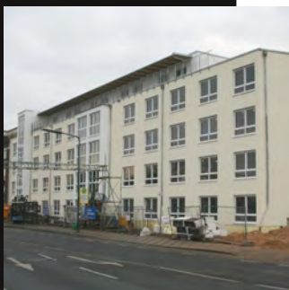
Fassade Werstener Feld in der Bauzeit
