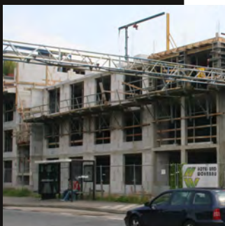
Fassade Werstener Feld in der Bauzeit
