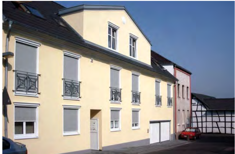
Straßenansicht von Osten
